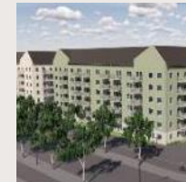
Lindallén, Uppsala 253 hyresrätter sålda till NREP
